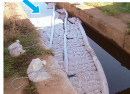
土のうでも支点になります。
