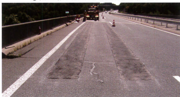
⑥わだち掘れ補修完了(即時交通開放可能)
