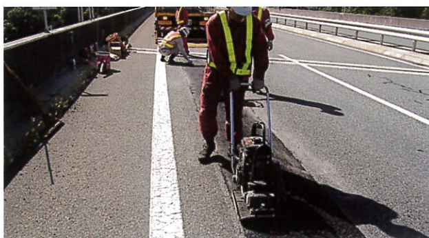
⑥わだち掘れ補修完了(即時交通開放可能)
